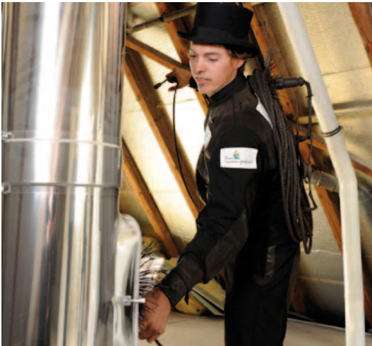
Ein Schornsteinfeger beim Kehren eines Schornsteins.
