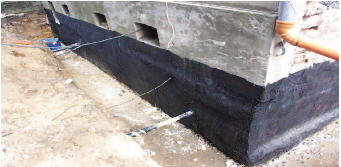
Aufwendig: Die Kellerdämmung von außen
